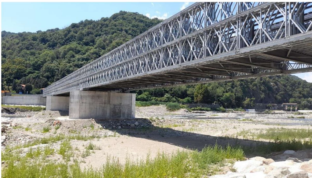
Figura 2 - Ponte provvisorio tipo Bailey in data 2022.
